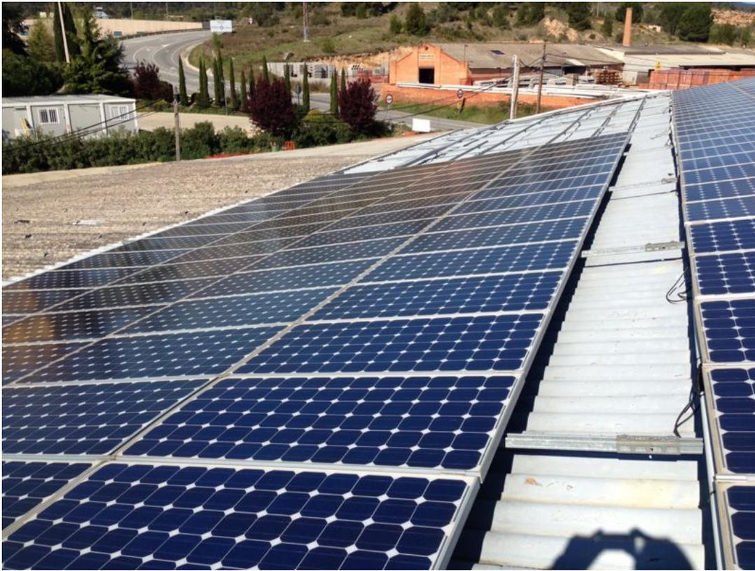
Bodega Industrial en Barcelona, Instalación de 85Kw con módulos Trinasolar
